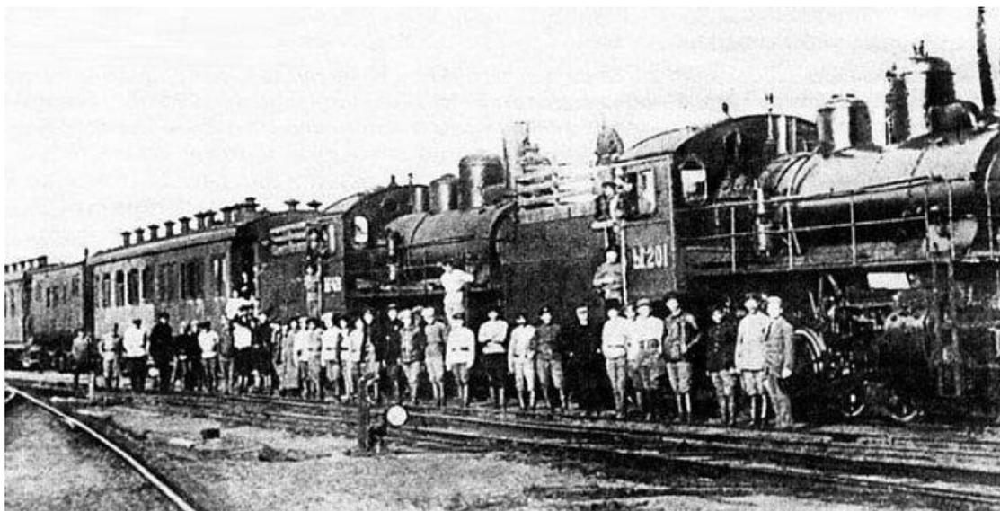
Рис. 14. Два курьерских паровоза серии  $K^2$ , сцепленных цугом. Вопреки широко распространенным утверждениям об использовании в поезде Троцкого мазутного отопления паровозов, на фотографии не видны баки для жидкого топлива, зато хорошо просматриваются наращенные дощатой решеткой борта тендеров. Это однозначно указывает на дровяное отопление паровозов
