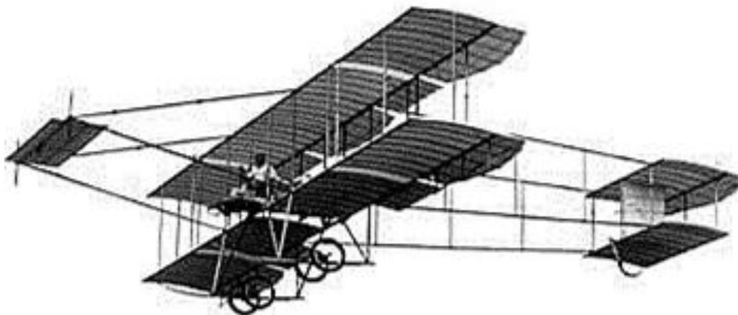
Рис. 12. Фарман-IV – один из самых массовых самолетов довоенного периода. Машина имела предельно простую конструкцию. Приборов на самолете не было совсем. Большинство военных летчиков Первой мировой войны учились летать именно на машинах этого типа. Благодаря простоте пилотирования, они оказались очень подходящими для этой роли. Максимальная скорость – 65 км/ч , потолок – 510 м
