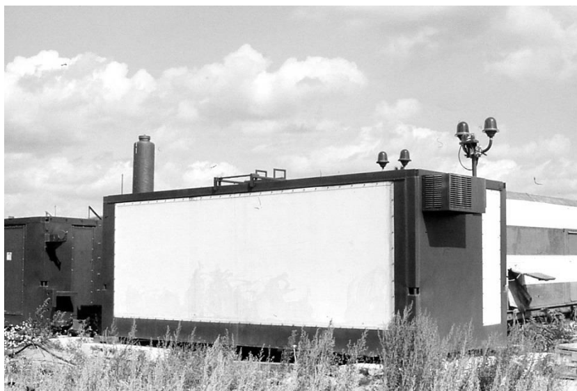
Рис. 1. Наземный азимутальный маяк системы посадки MLS «Плацдарм-1Н» III категории
