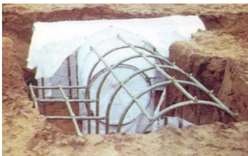
Рис. 4.14. Блиндаж из унифицированных элементов УЭПИ-7
