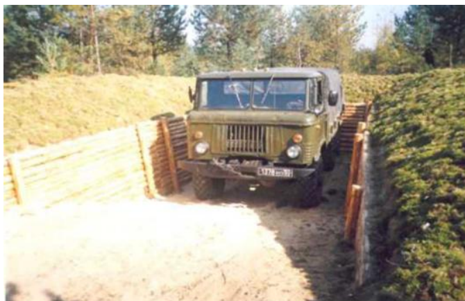
Рис. 3.14. Сооружение для защиты автомобильной техники
