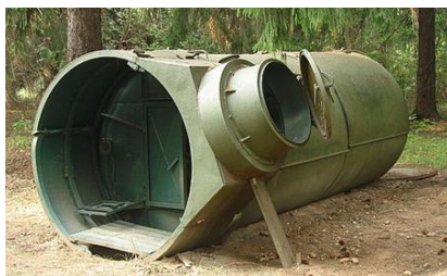
Рис. 4.8. Быстроизвлекаемое металлическое сооружение «Пакет»
