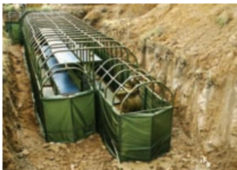
Рис. 4.15. Легкое каркасно-тканевое убежище (ЛКТУ)
