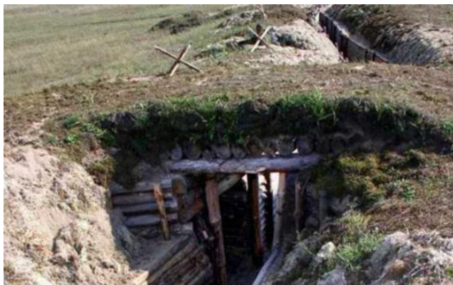
Рис. 4.3. Перекрытый участок траншеи
