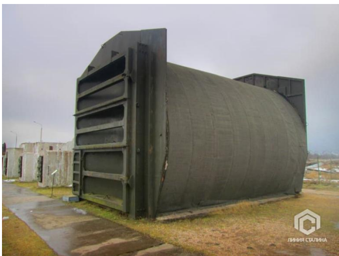
Рис. 4.11. Сборное железобетонное фортификационное сооружение «Гранит»
