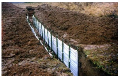
Рис. 2.4. Усиление крутостей из лесоматериала и табельного комплекта (возимый материал)
