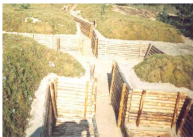
Рис. 2.4. Усиление крутостей из лесоматериала и табельного комплекта (возимый материал)
