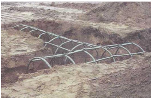
Рис. 4.13. Перекрытая щель из унифицированных элементов УЭПИ-6
